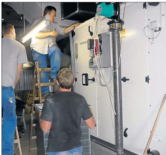
Die Arbeit der Monteure auf der Baustelle ist fast immer Teamwork.
